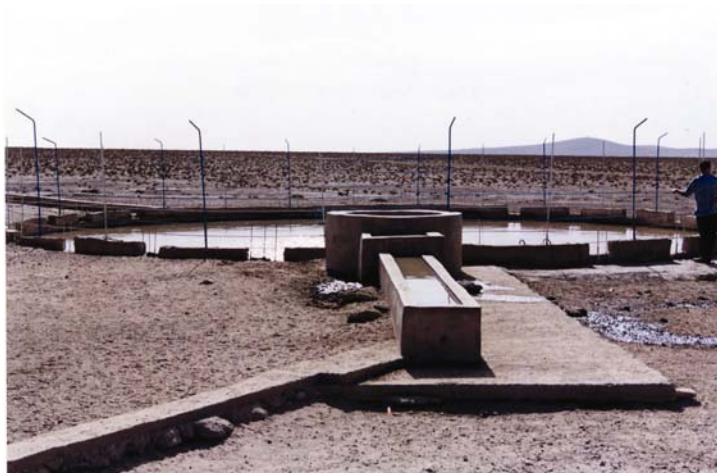
Un exemple d'exploitation des eaux de surface par la mise en place d'abreuvoirs
