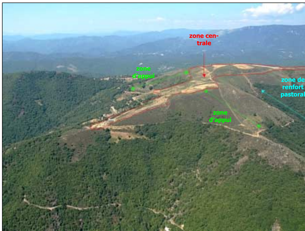
Figure 4 : Un exemple de coupure de combustible pastorale en Hautes Cévennes gardoises (Bonnevaux, Gard)
