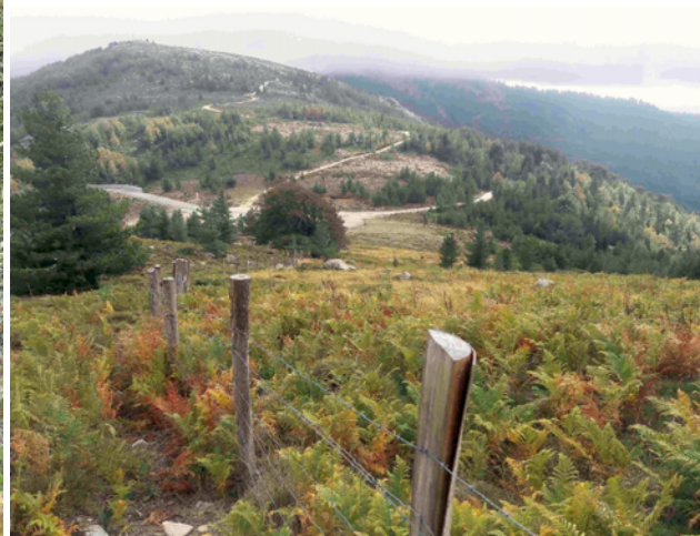
SOTTO , REALIZZAZIONE DEI RECINTI (CL. LEBRE)
