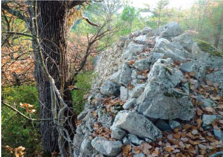
Ill. 8 : Site de Belly, mur de soutènement en pierres sèches.
